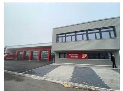
Das neue Feuerwehrhaus in Görwihl-Rüßwühl
