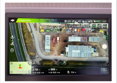
Unterstützung der Abschlussübung Baustelle neues KKH
